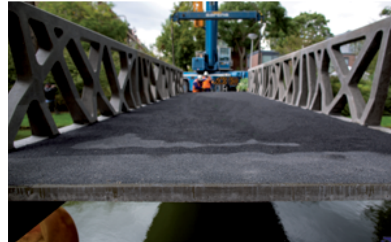
Foto | Door het gebruik van UHSB heeft deze brug in Rotterdam een lage CO 2 -footprint. Foto: Peter Buitelaar.
