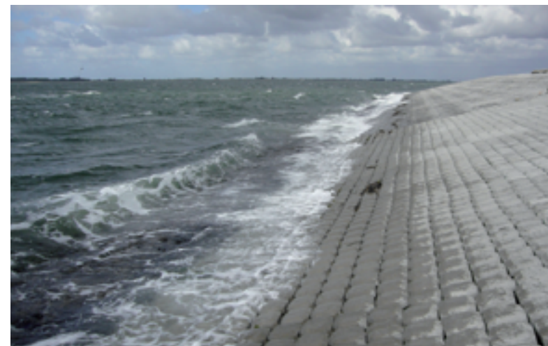
Foto | Slim vormgegeven dijk-bekleding met 30% gewichtreductie
