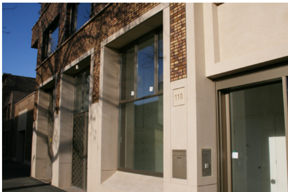
Prachtige harmonie tussen architectonisch prefab beton en metselwerk; een aanwinst voor het stedelijk beeld van Rotterdam.
