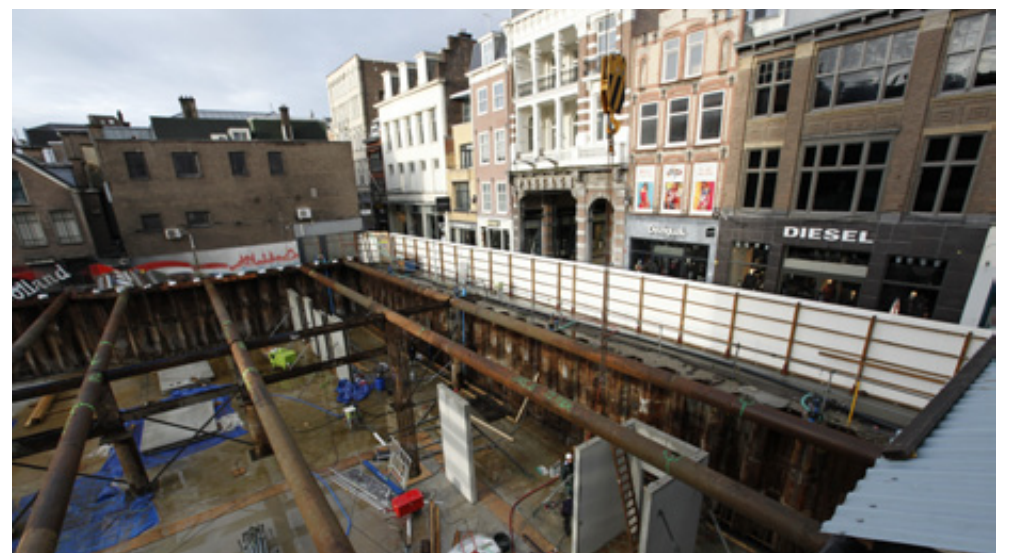
Just in time leveren en monteren: de eerste prefab betonelementen voor de bouw van een nieuw stukje Haagse binnenstad.
