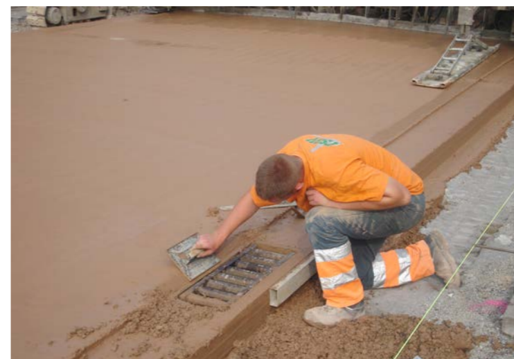
Gekleurd beton wordt meestal verkregen door de toevoeging van een pigment in poedervorm. Deze kleurstoffen zijn zeer fijn (gemiddelde korrelgrootte van 0,2 tot 1\text{ }\mu\text{m} ) en vragen dus veel water. Om de bestandheid van het beton tegen vorst-dooicycli te behouden, is het essentieel het watergehalte van het mengsel niet te verhogen en het eventueel verlies aan verwerkbaarheid op te vangen door de toevoeging van een plastificeerder.
