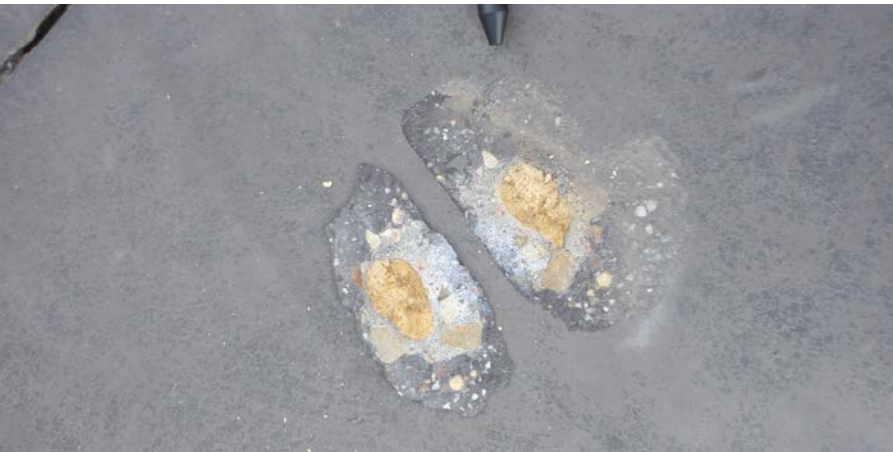
Wanneer een poreus en met water verzadigd granulaat bevriest, treedt intern een waterdruk op waardoor het kan barsten. De bevroering van granulaten in beton komt sterker tot uiting aan het oppervlak: plaatselijk treden barsten op en vormen zich kleine kratertjes (popouts).
