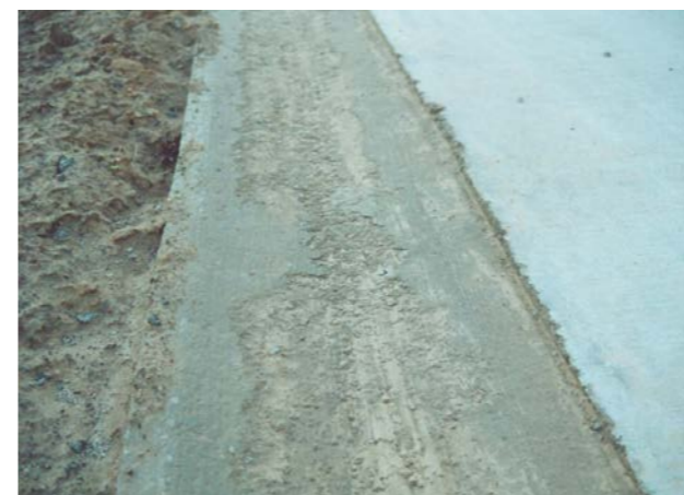
Voorbeelden van vers beton dat aan vorst werd blootgesteld: - straatgoot en boorkern genomen in het beton; het beton heeft niet langer een compacte structuur
