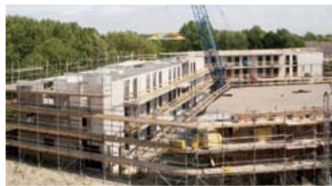
Razendsnel assembleren en later nog aanpasbaar voor ander gebruik.
