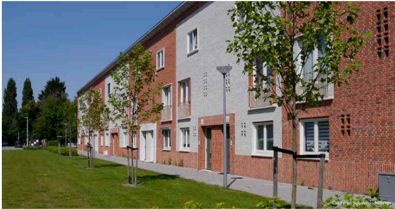
Spelen met kleuren, metselwerkdetailleringen en witte prefab betonelementen: een woonwijk met allure.
