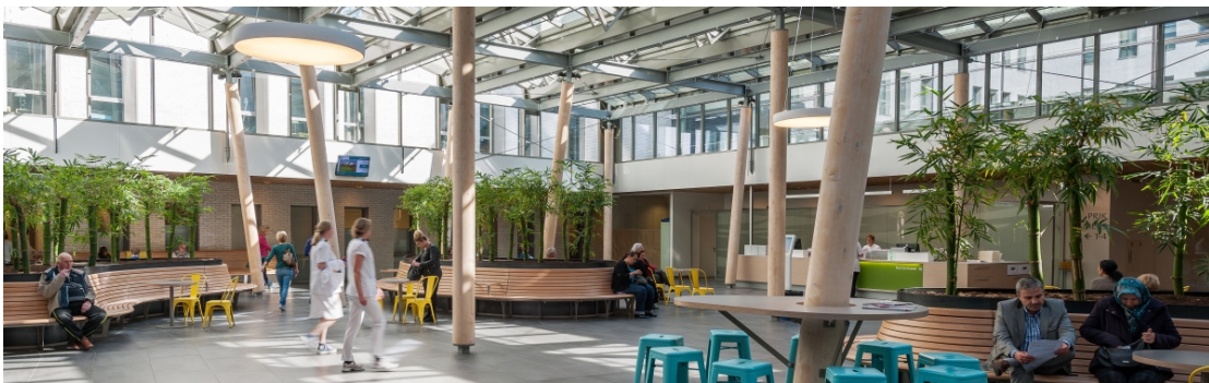
Thermisch geactiveerde betonvloeren in het Meander Medisch Centrum in Amersfoort (foto Dirk Verwoerd)
