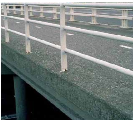
Betonnen rand bij een viaduct ...
