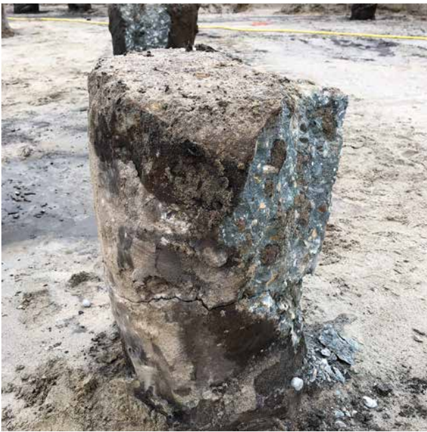
Snellen van paalkoppen dient zorgvuldig te gebeuren. Zonder inzagen kunnen ongecontroleerde breukvlakken ontstaan.
