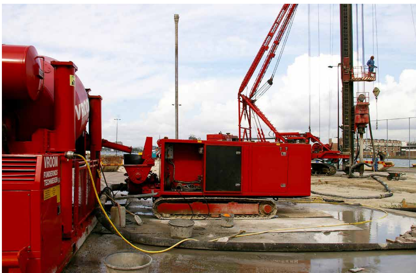
Het verpompen van beton.
